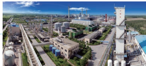
Dingzhou, Hebei 河北定州
